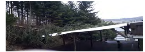
Wegen Sturmschaden: Sanierung Vorplatz.
